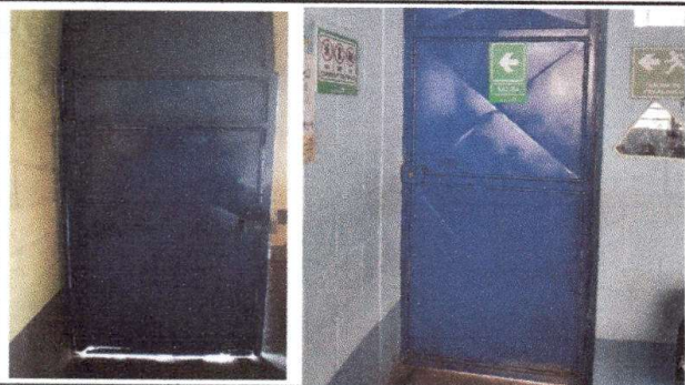
Foto 1: mantenimiento de puertas colocacion de un pedazo de lamina en la parte inferior.
