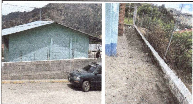
Foto 3: reaparación de muro perimetral de block en la cocina escolar.
