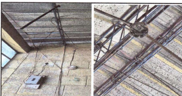
Foto 5: reparacion del sistema electrico.
