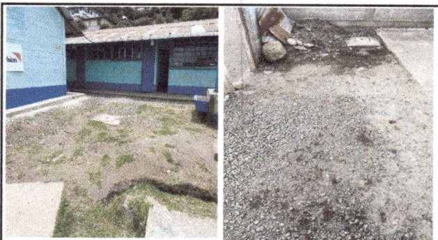
Foto 4: reaparación de plancha de concreto de patio.
